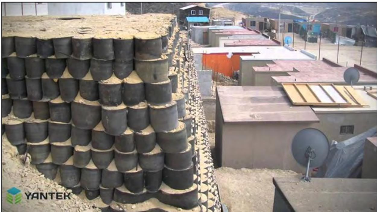
**Imagen 2. Muro de contención y solar de vivienda contruidos por Yantek.**
